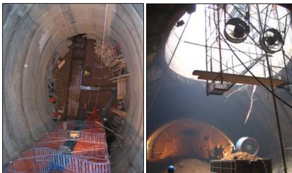
Fig. 6. Pozo de ataque elíptico, Línea B, 2005.
