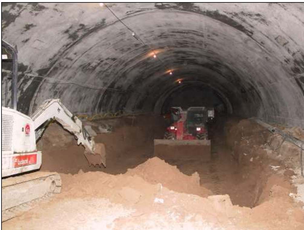
Fig. 2. Túnel Línea H, método belga, 2002.
