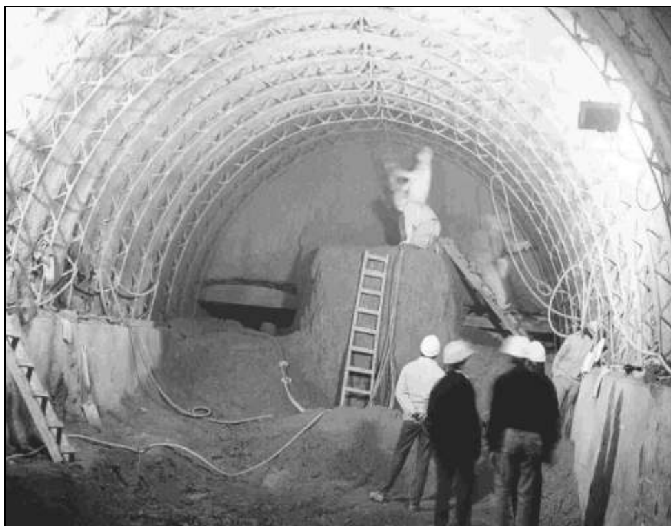
Fig. 1. Túnel Línea B, método alemán, 1999.
