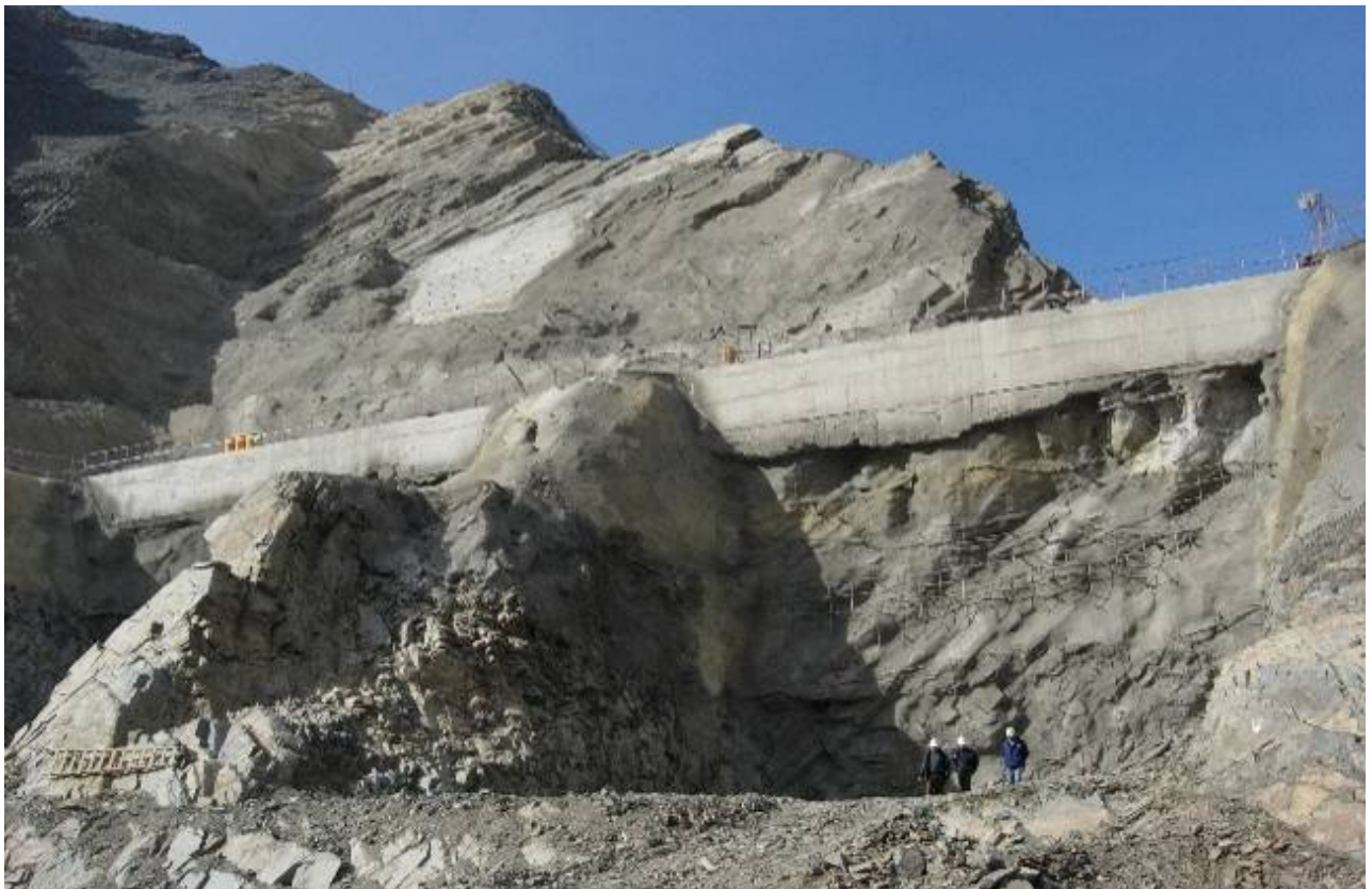
Figura 5. Vista general de la obra de embocadura del aliviadero en Julio de 2006, con piso de la excavación en cota 1098, restando aún 12 metros para excavar.
